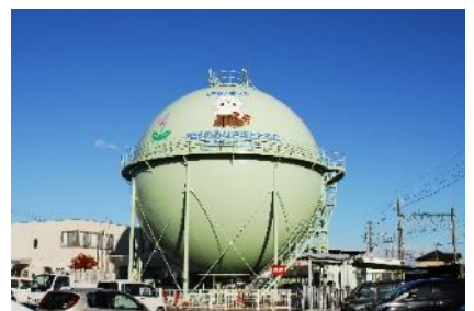
△佐野ガスのガスタンク
