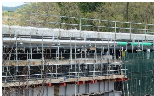
橋梁へのガス管添架工事▷
